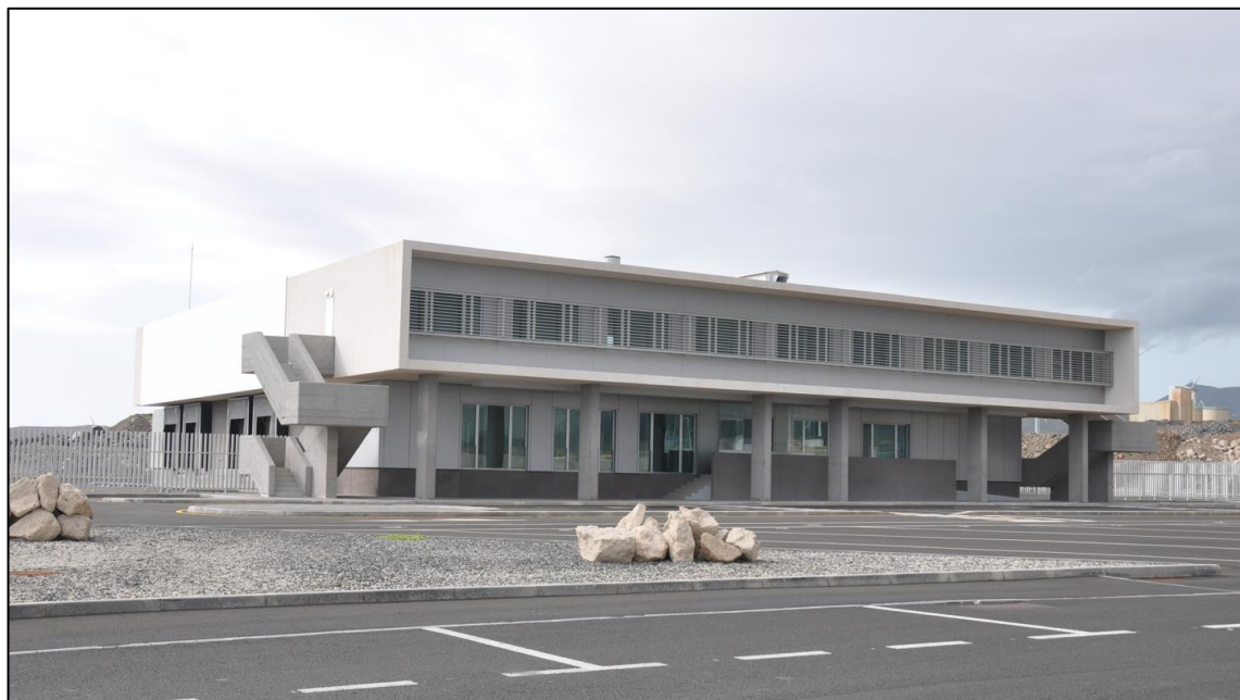
Figura 4 Centro de Inspección Portuario del puerto de Granadilla finalizado (30/12/2022)
