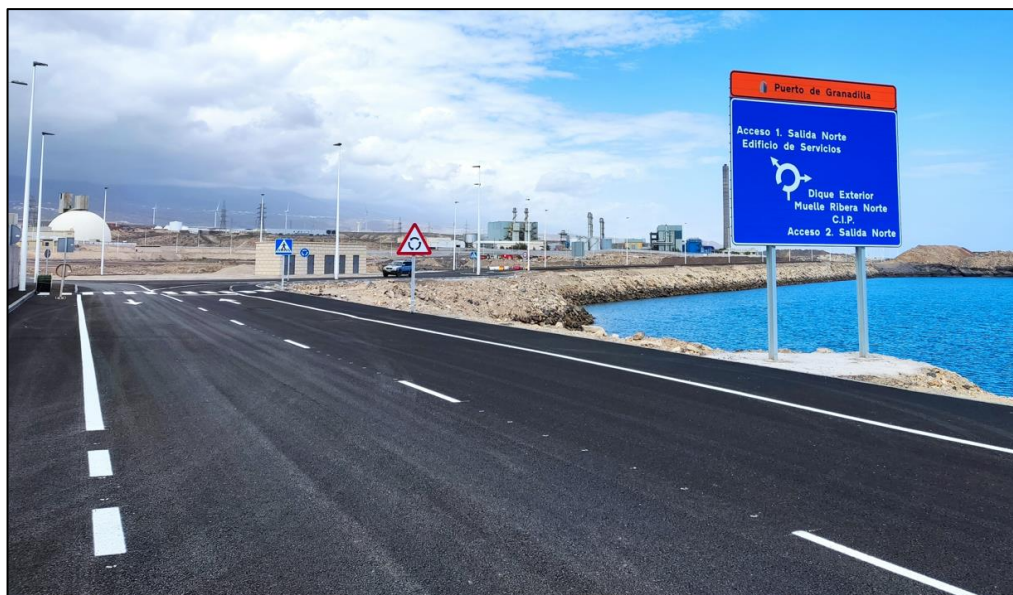
Figura 5 Viario en contradique del puerto de Granadilla
