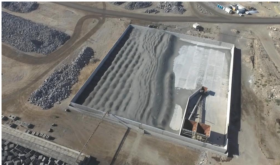
Figura 17. Depósito de arena construido en la explanada del puerto de Granadilla
