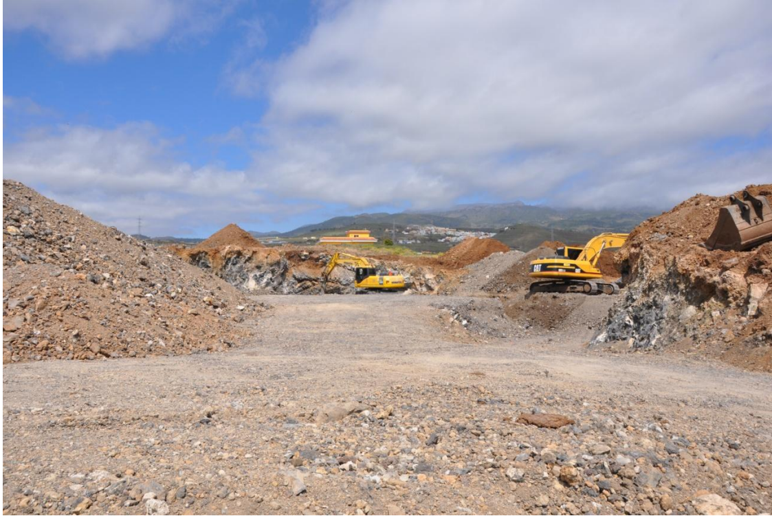
Foto tomada en la visita de 28/05/2014
