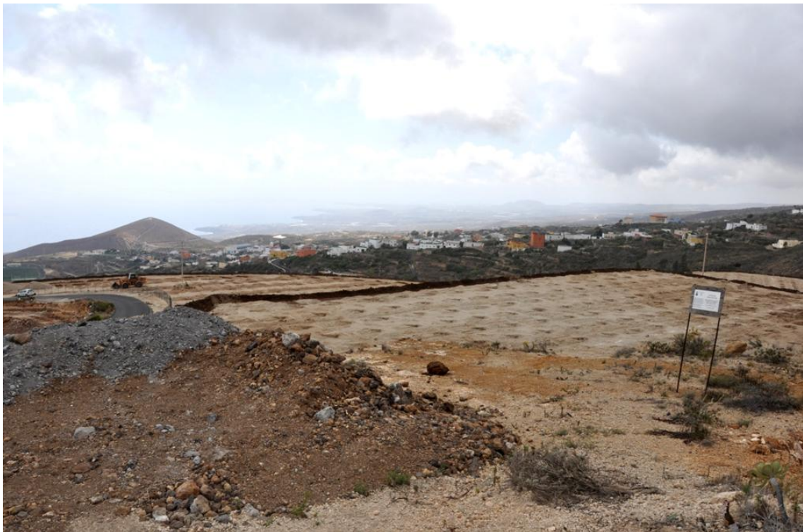
Foto tomada en la visita de 01/10/2014
