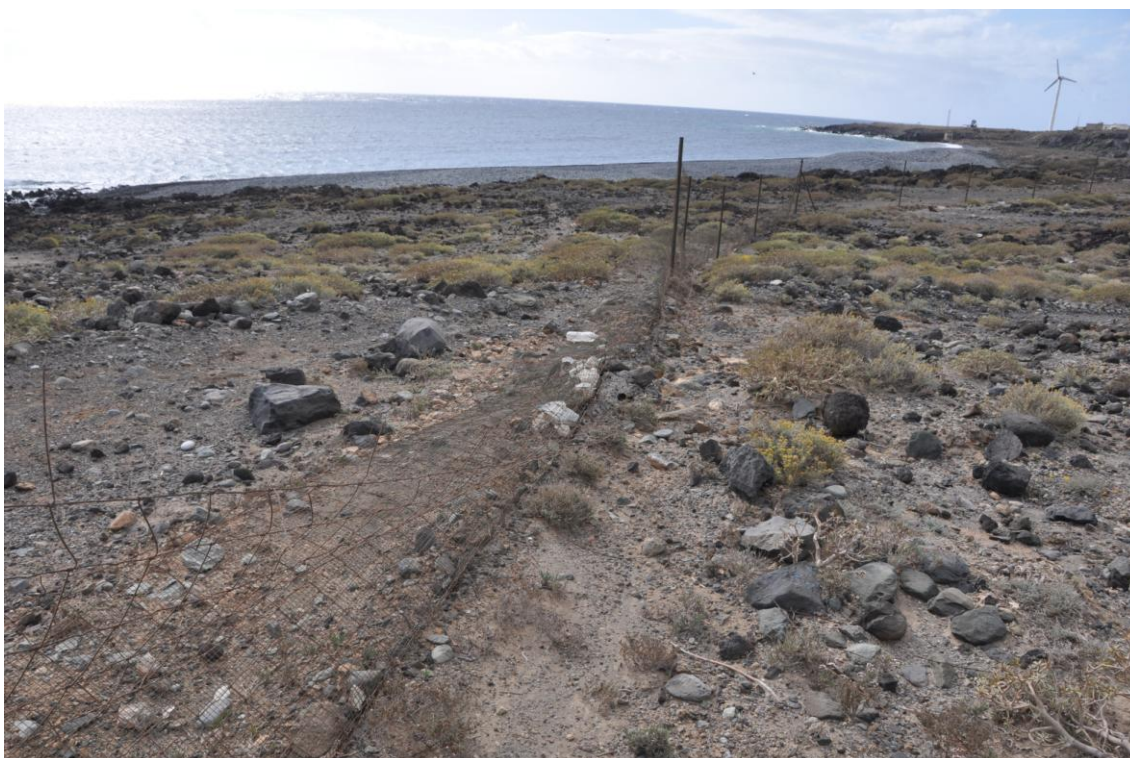
Figura 2. Valla perimetral rota
