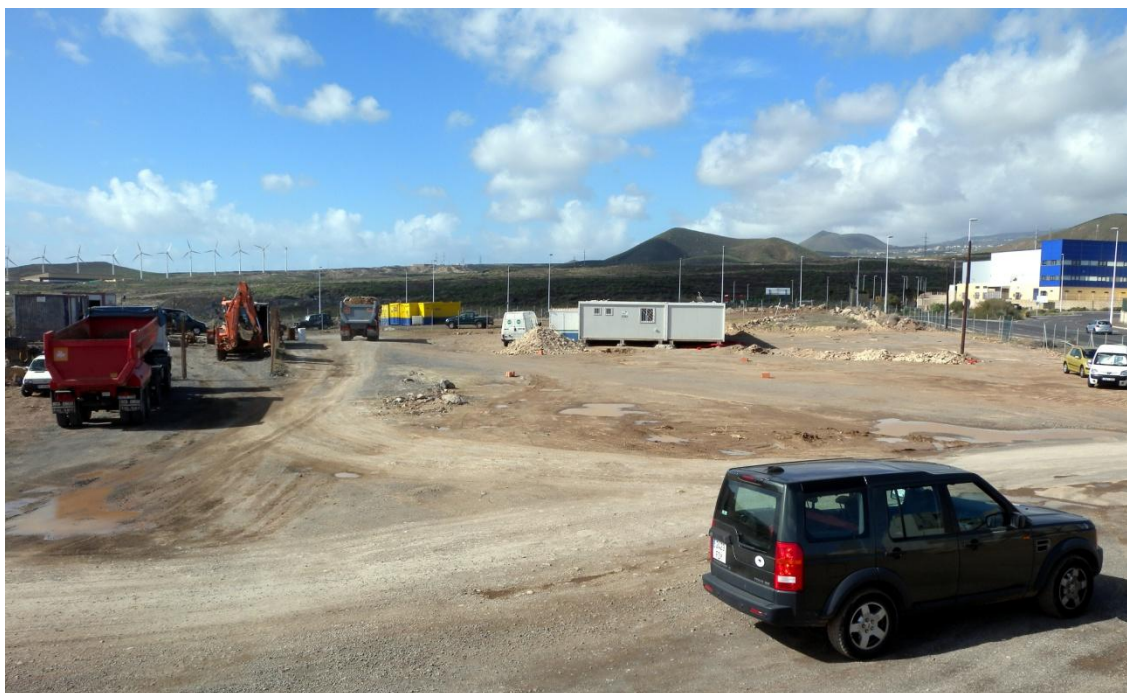
Figura 7. Zona de concentración de oficinas, báscula y servicios logísticos
