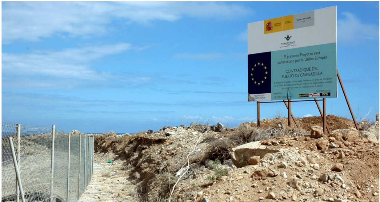
Figura 5. Señalización y vallado perimetral de la zona de obras
