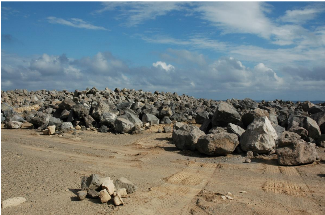
Figura 14. Acopio de materiales para la escollera
